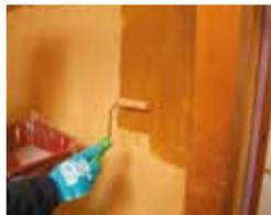
ローラーバケでは塗りにくい隅から先にハケで塗りましょう。隅が塗り終わったら、ローラーバケで全体を塗ります。水性下塗剤は粘度が低く(水のような感じ)、たれやすいので塗る前にローラーバケや塗り皿でよくしごいてください。中毛タイプのローラーバケをおすすめします。
