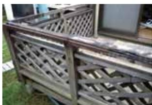
屋外にさらされている木は年月が経つと色があせ、さらに劣化が進行すると木そのものが黒ずみ、腐食していきます。劣化が進行しすぎると、ステインタイプでは黒ずんで傷んだ表面を再生できない場合があります。そのような場合は、木目を隠す仕上りのペイントで塗り替えをおすすめいたします。
