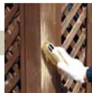
表面の劣化が激しい場合(手で触ってボロボロ落ちる状態)は、サンドペーパーをかける前に予め皮スキやワイヤーブラシで取り除いてください。
