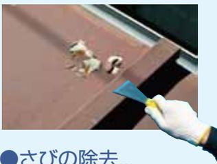
はがれて浮いている塗膜は皮スキやワイヤーブラシで削り落とし、#240程度のサンドペーパーで塗装面を平滑にしてください。しっかり密着している塗膜は、そのまま残してもOKです。
