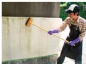
泥や苔、藻による汚れやチョーキング\*により粉っぽくなった表面は、タワシやデッキブラシ等で落としよく水洗いをしてください。雨じみ等落ちにくい汚れは、完全に落としきれなくても出来るだけ落としてください。洗浄は表面の粉っぽさがなくなったらOKです。
