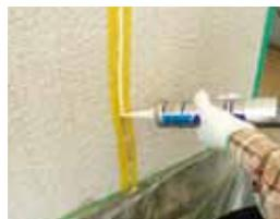
塗料の上塗りができるシーリング材で補修しましょう。まずは両側にマスキングテープを貼ってはみ出しを防ぎ、シーリング材をつめこんでいきます。それから余分なシーリング材をヘラなどで削ぎ落とします。**必ず塗料の上塗りが可能な乾燥時間をとってください。**
